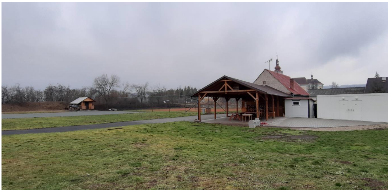
Obr. 2 - Technické zázemí na sportovním hřišti
