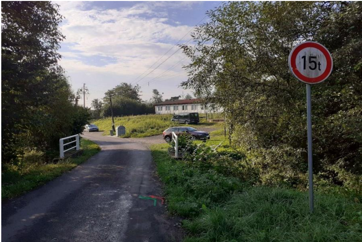
POHLED NA MOSTEK
