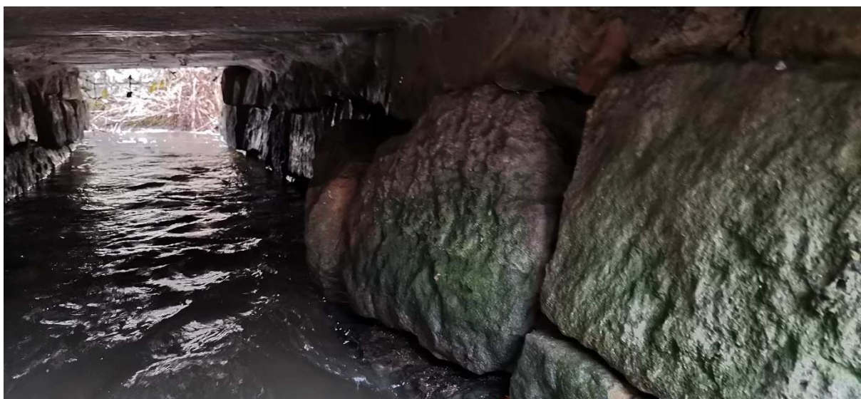
POHLED DO PROPUSTKU
