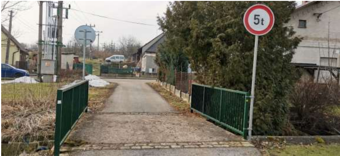
POHLED NA PROPUSTEK
